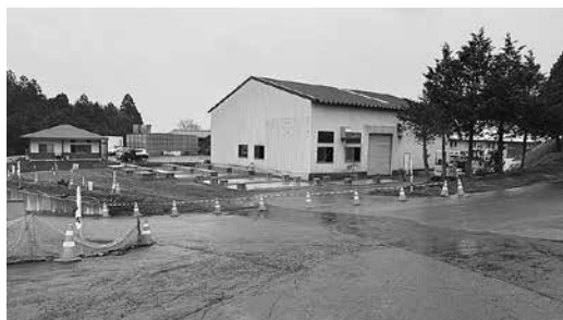
建設中の発電センター
