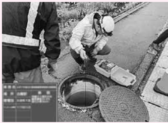
町も調査点検してます
